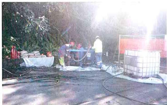
*Kit antipollution sur zone de travail (g.) – zone d'injection et récupération des coulis de béton des forages (d.)*
