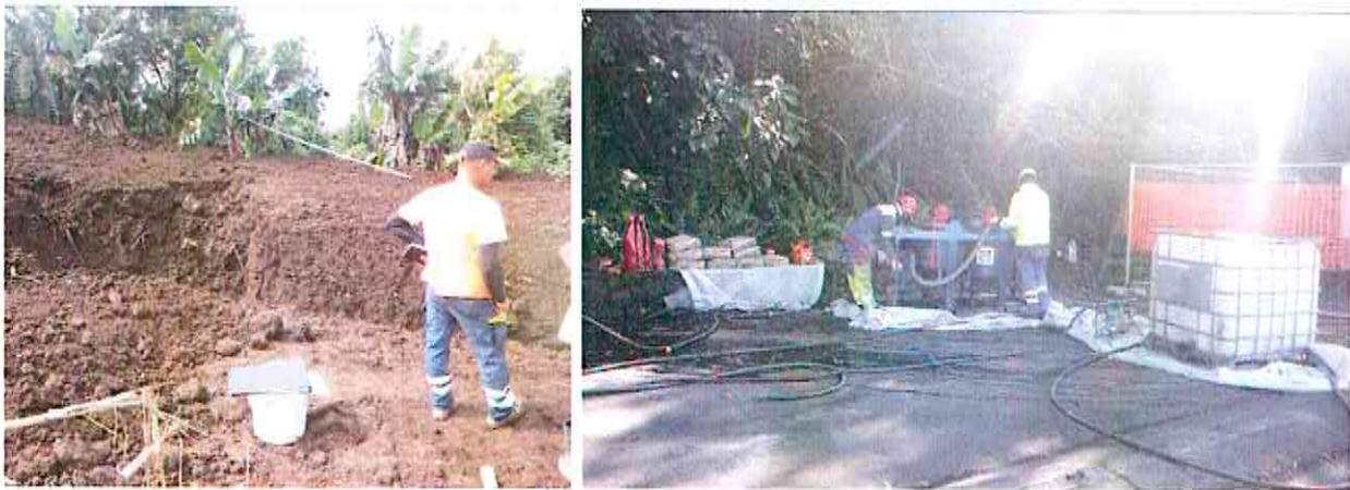
*Kit antipollution sur zone de travail (g.) – zone d'injection et récupération des coulis de béton des forages (d.)*
